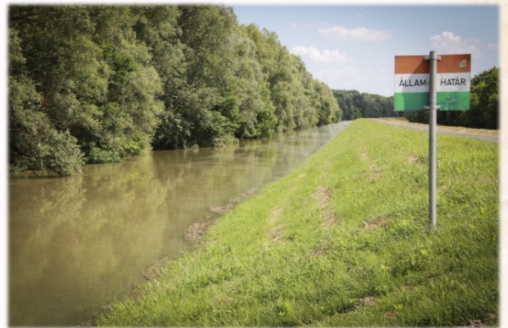
Boki gátörjárás, Mohácsi árvízvédelmi szakasz
