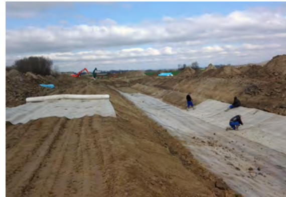
Tápcsatorna szigetelése
