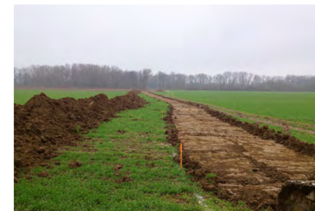
Tápcsatorna építésének előkészítő munkái (humuszolás)
