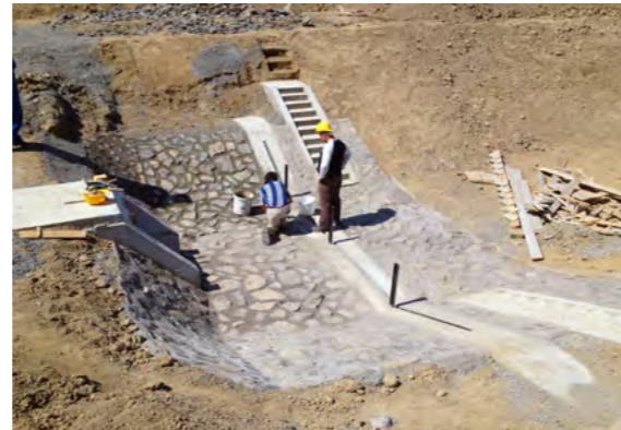
Tápcsatornában épülő keretelem átteres és halrás
