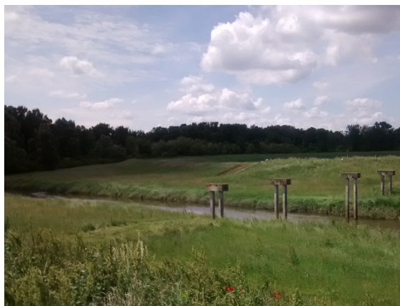
Meglévő hídpillérek a Fekete-vízen
