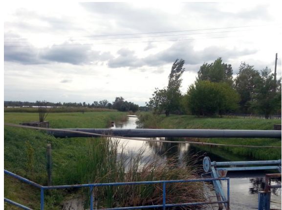
Ordai árok - szivattyútelep szívócsatornája
