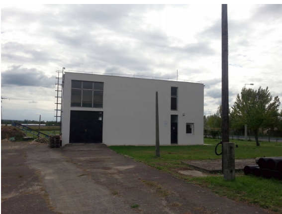
Ordacsehi szivattyútelep - kezelőépület
