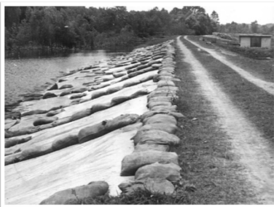
Fóliázás a Lanka-szivattyútelep mellett
