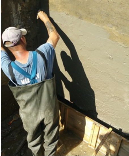
8. ábra A mentett oldali zsilipakna kezelése Xypex® Concentrate-tal
