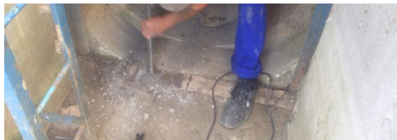
7. ábra A Gréda-Lugi zsilip mentett oldali zsilipakna küszöbrész bontása
