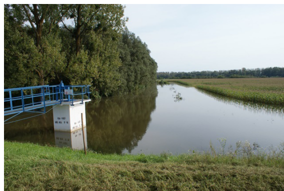
2. ábra A Gréda-Lugi zsilip hullámtéri aknája a 2014-es drávi árvízkor
