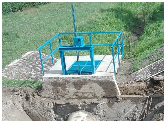
5. ábra A Gréda-Lugi zsilip mentett oldali részének feltárása
