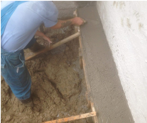
9. ábra A Gréda-Lugi zsilip mentett oldali zsilipakna hibás betonrész helyreállítása
