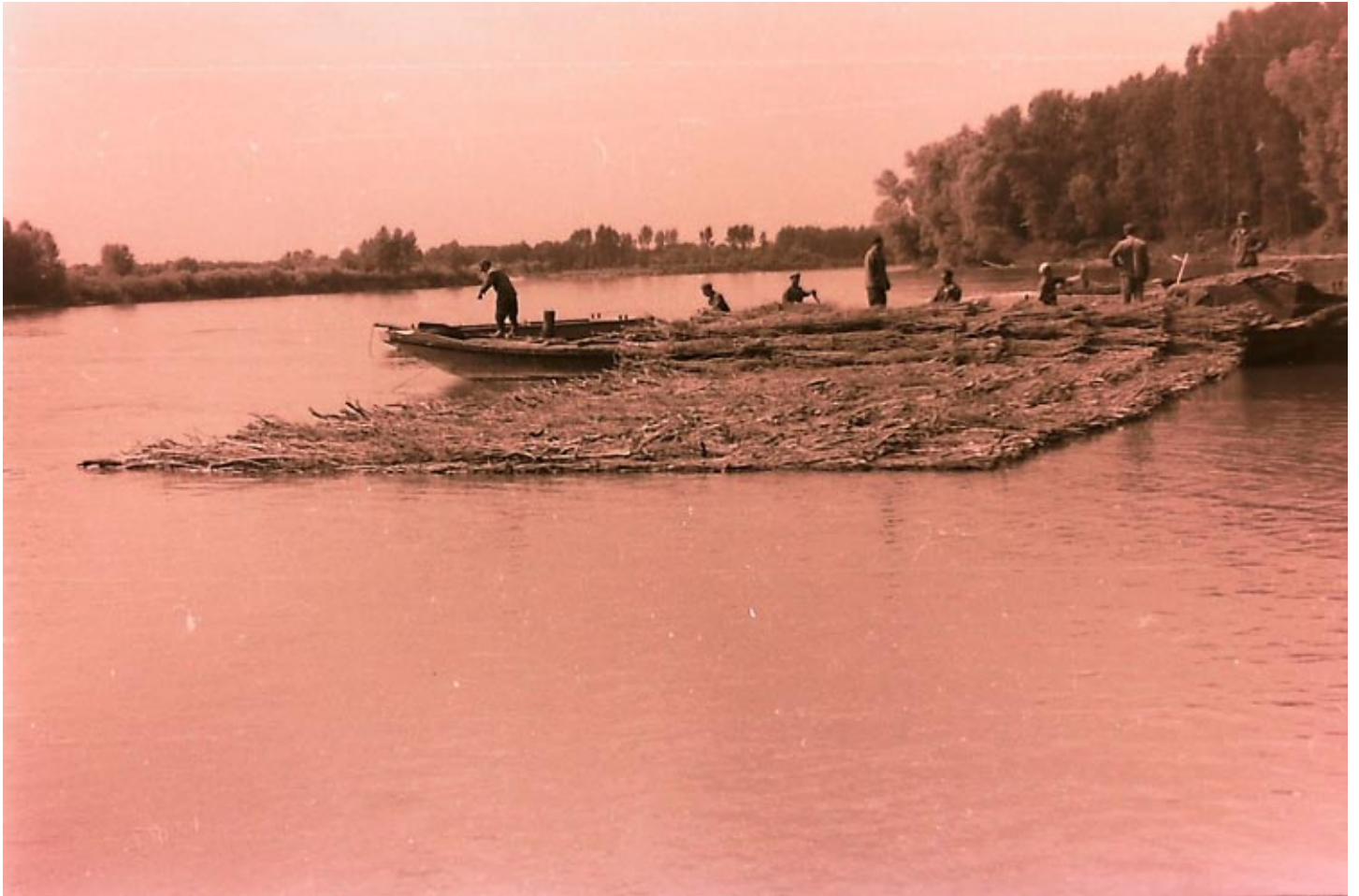
Rőzsepokrócos partborítás építése, 1960.
