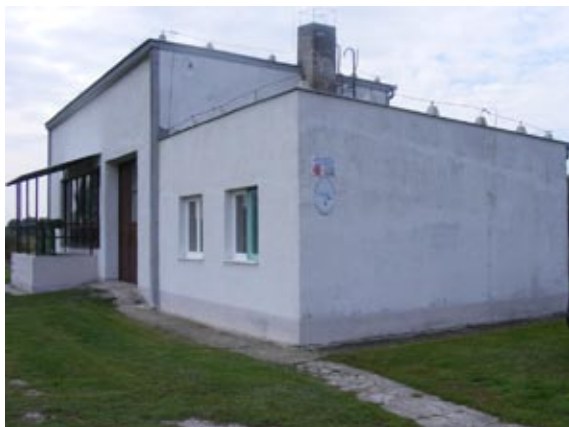
Gerecháti szivattyútelep felújítás (tetőszigetelés és nyílászárócseré) után
