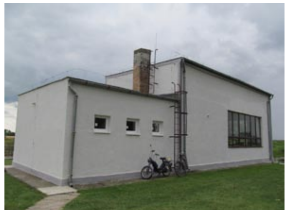
Vizslaki szivattyútelep felújítás (tetőszigetelés és nyílászárócseré) után
