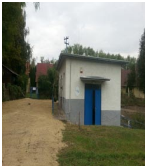
Szántódi szivattyútelep felújítás után
