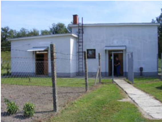
Kölkedi szivattyútelep felújítás (tetőszigetelés és nyílászárócsere) után
