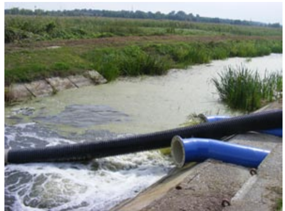
Zamárdi-Tóközi szivattyútelep épülete felújítást és nyomócső cserét követően
