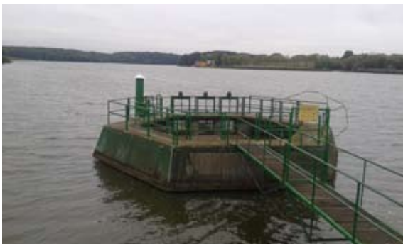
A bukóaknás árapasztó és üzemi műtárgy
