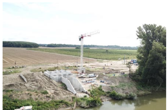
Az épülő drávai vízkivételi mű madártávlatból
