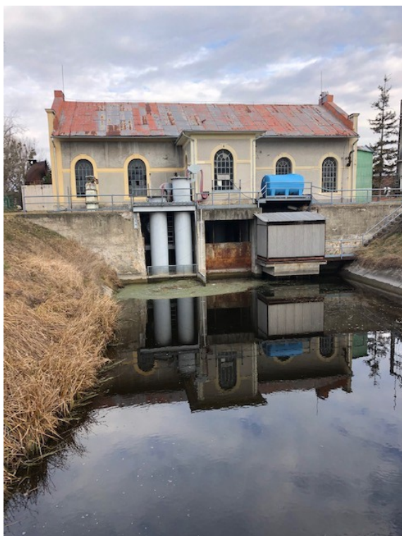
1. sz. kép: Szivattyúház
