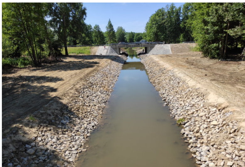
Babócsai-Rinya, Nagyatád – az elkerülő híd felvízi szakasza a helyreállítás után
