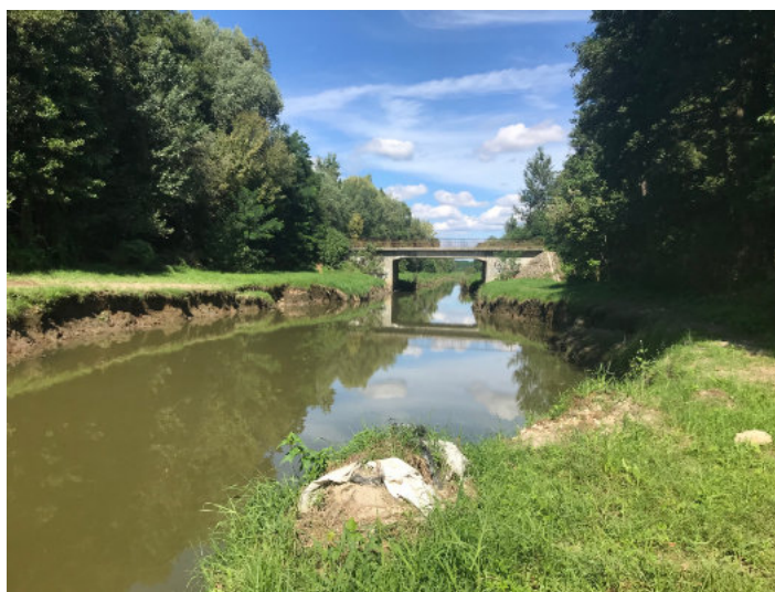
A nagyatádi elkerülő híd, a munkálatok előtt
