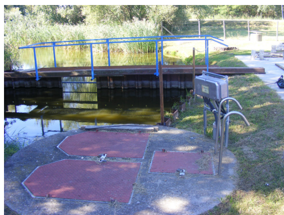
Szádlemezelt szivótér és szivóakna
