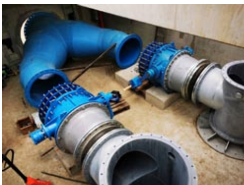
Nyomóágak szerelés közben és a szivattyú beépítése
