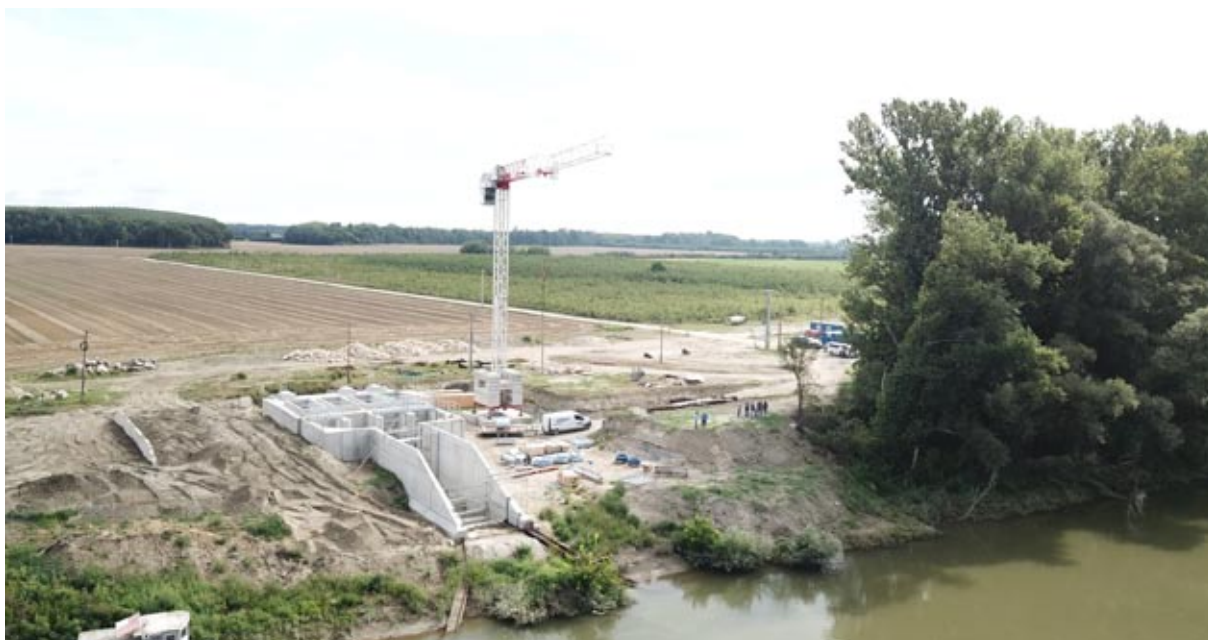
Vízkivételi mű építési munkák közben
