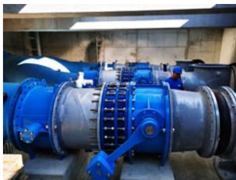
Nyomóágak szerelés közben és a szivattyú beépítése
