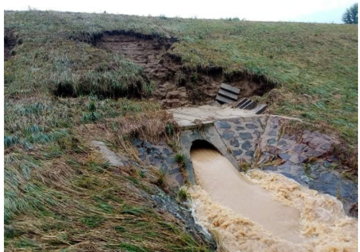
2. Kimosódás és rongálódott lejáró lépcső
