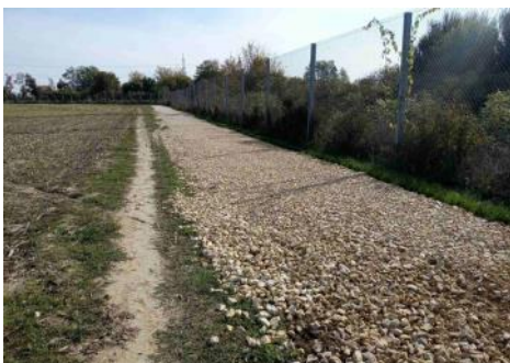
IBH mentén makadámút kialakítása
