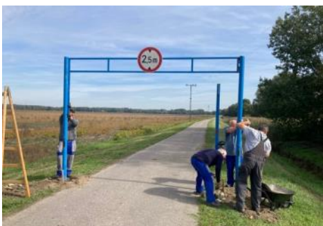
Új magasságkorlátozó kapu telepítése
