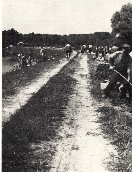
5. ábra. Árvédekezés a Dázsony-dárdai árvédelmi töltés Lanka szivattyútelepe alatt
