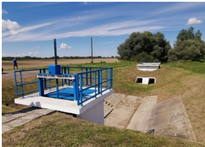
Árvízvédelmi műtárgy a 05. 03. számú drávasztárai árvízvédelmi szakaszon – 2021. 08. 31.
