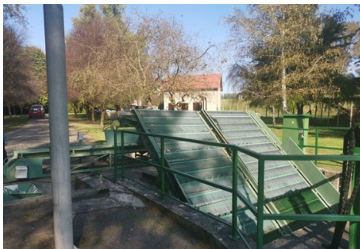
Bédai szivattyútelep - gereb műtárgy
