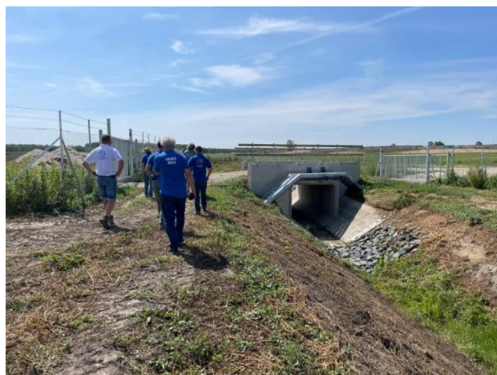
Buzsák-keleti vízfolyás elkészült kotrasi munkái Fotók: Váradi Nelli - DDVIZIG
