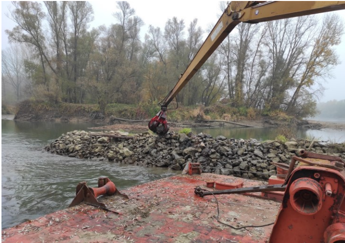
Kő eltávolítása polipos úszó munkagéppel
