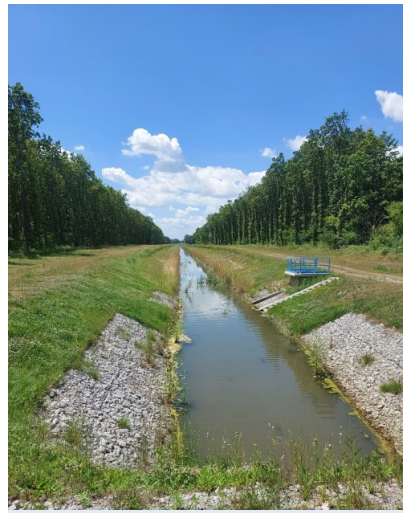
A Főcsatorna jelenlegi mederteltsége Fotó: Patak István - DDVIZIG
