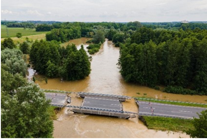
3. fénykép. Az elmosott közúti híd Forrás: Irodalomjegyzékben
