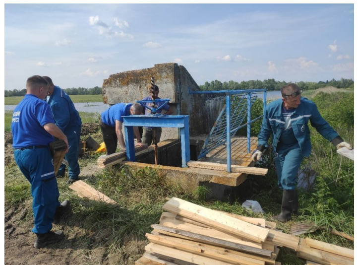
Bogádi-szárító torkolati műtárgy elzárás
