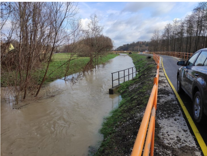
3. számú melléklet: A vésztározó 2. számú hosszöltésén a kerékpárút korlátai 2023. decemberében
