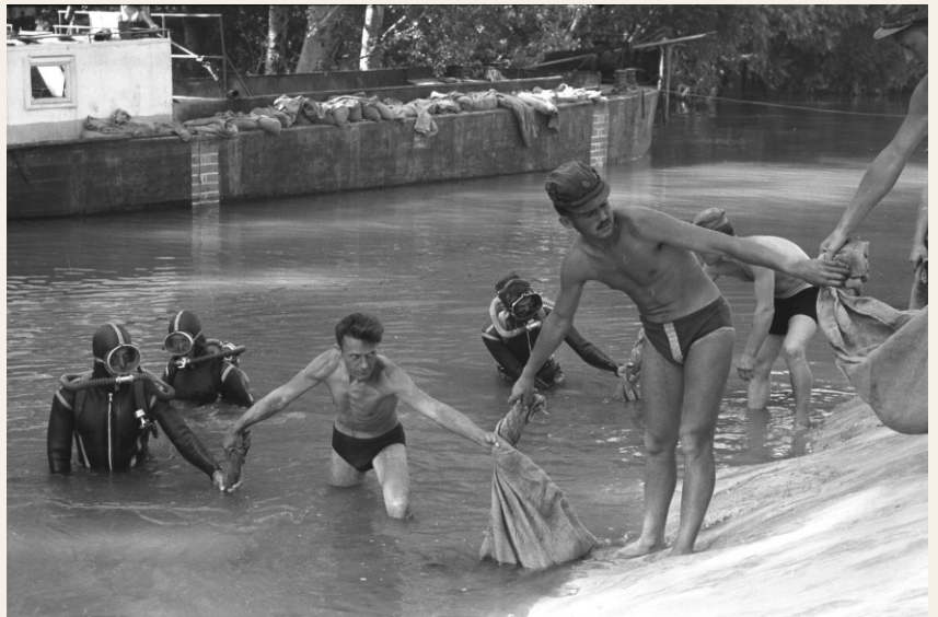
Fólia leterhelése. Az 1965-ös árvíz idején alkalmaztak először műanyag fóliát (Pártia fóliát) az árvízi védekezéshez.
