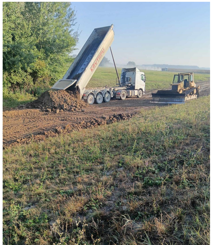
Dráva bal part 22+770 – 24+238 tkm szelvények között nyomópadka kialakítása Fotó: Füles Ferenc – DDVIZIG
