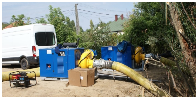
Dunaszekcső – AGROFIL szivattyúállás az ideiglenes elzárásnál
