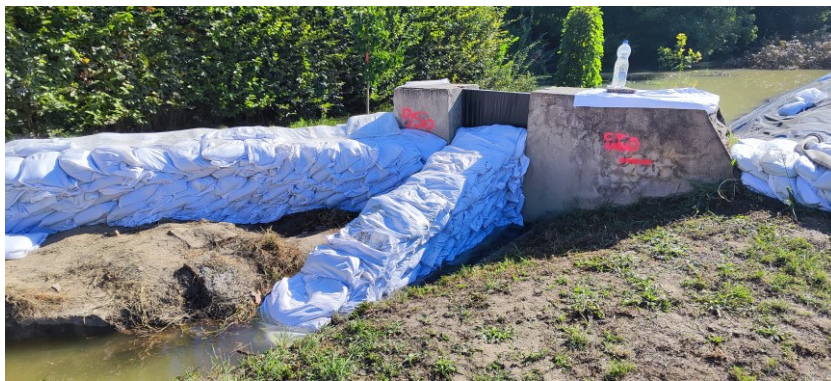
Dunaszekcső – depónia megerősítés Fotó: Bencs - Drahos Olga – DDVIZIG
