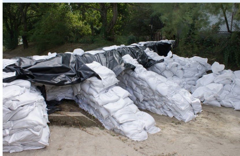
Dunaszekcső – nyúlgát bordás megtámasztással Fotók: DDVIZIG
