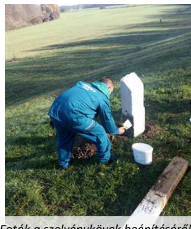
Fotók a szelvénykövek beépítéséről (SSZM Drávaszabolcsi Felügyelőség)
