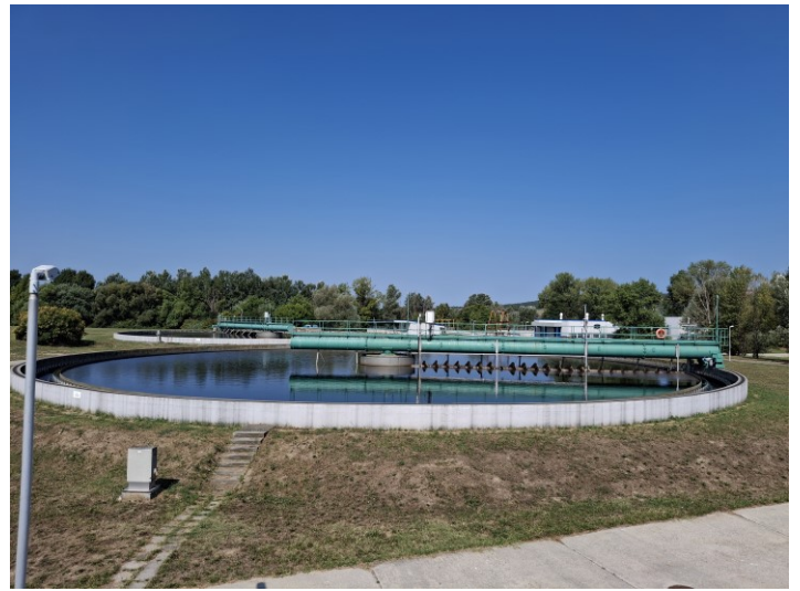
A vízműtelep műszaki paramétereinek ismertetését követően bejártuk a technológiai létesítményeket.
